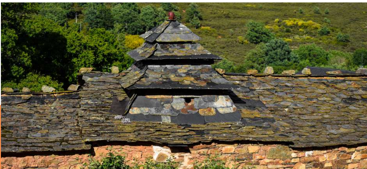
Figura 5: Ejemplo de arquitectura cabreiresa (Obtención propia).
